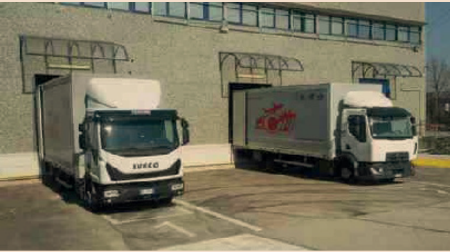
Esterno magazzino della GM International
